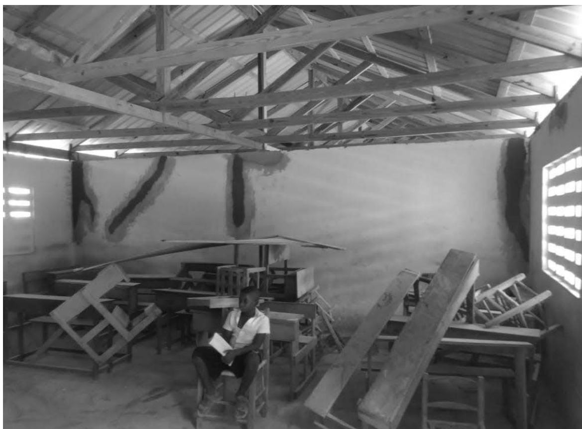
Dory – Un élève pose au milieu des travaux de réparation de sa classe.
